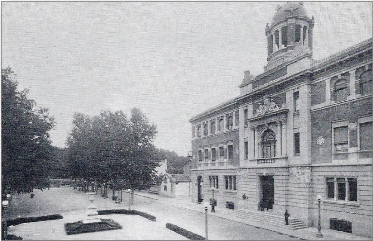
Antic edifici de Correus i Telègrafs de Girona.
